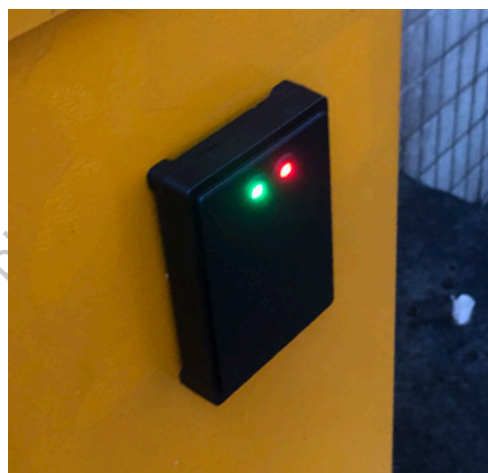
4. Вид спереди после установки
